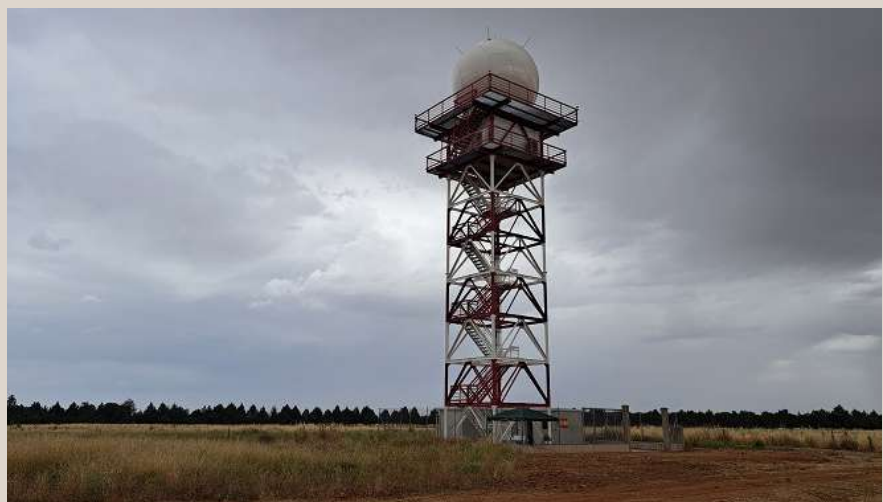
Nuevo radar meteorológico instalado en la Base Coronel Sánchez Bilbao, en Almagro (Ciudad Real)
