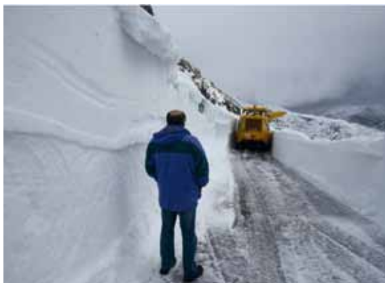
Despejando de nieve la carretera Sotres-Tresviso.
