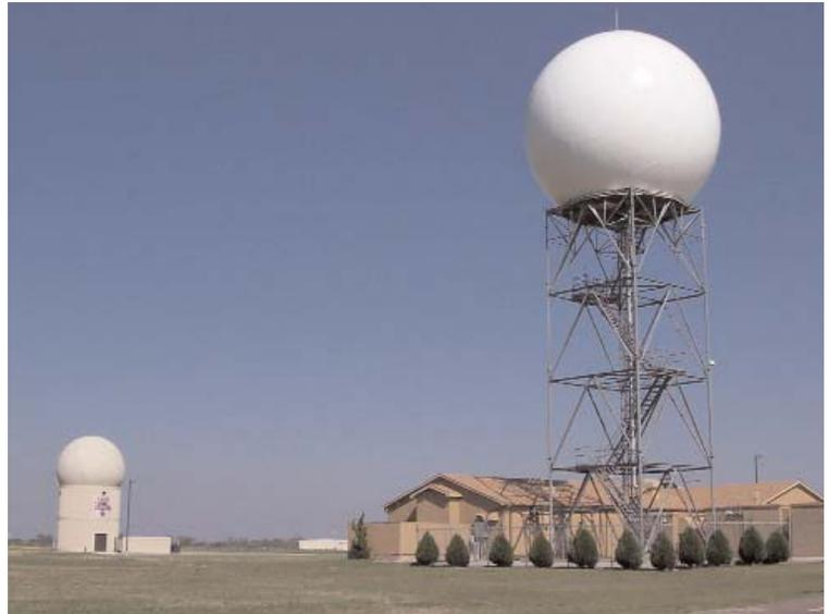
Radares WSR-88D (derecha) y de arreglo de fases (izquierda) del NSSL
