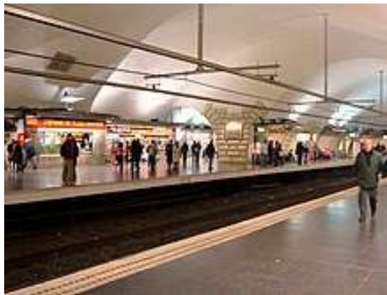
Parada del metro en plaza España (Barcelona), donde puede apreciarse la bóveda original, construida por Terradas.
