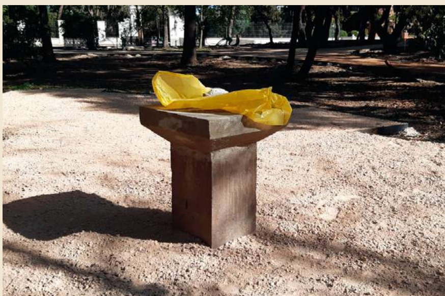
Pedestal instalado el 7 de abril en el lugar donde estaba, ya muy deteriorado, el original (Fuente: Ayuntamiento de Madrid)
