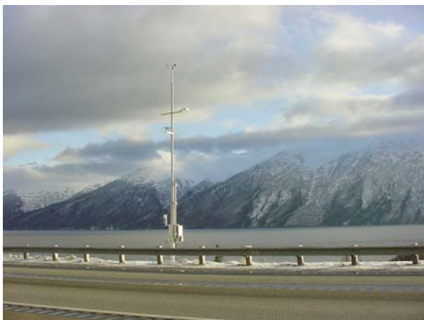
Estación meteorológica de carreteras en Alberta (Canadá)
