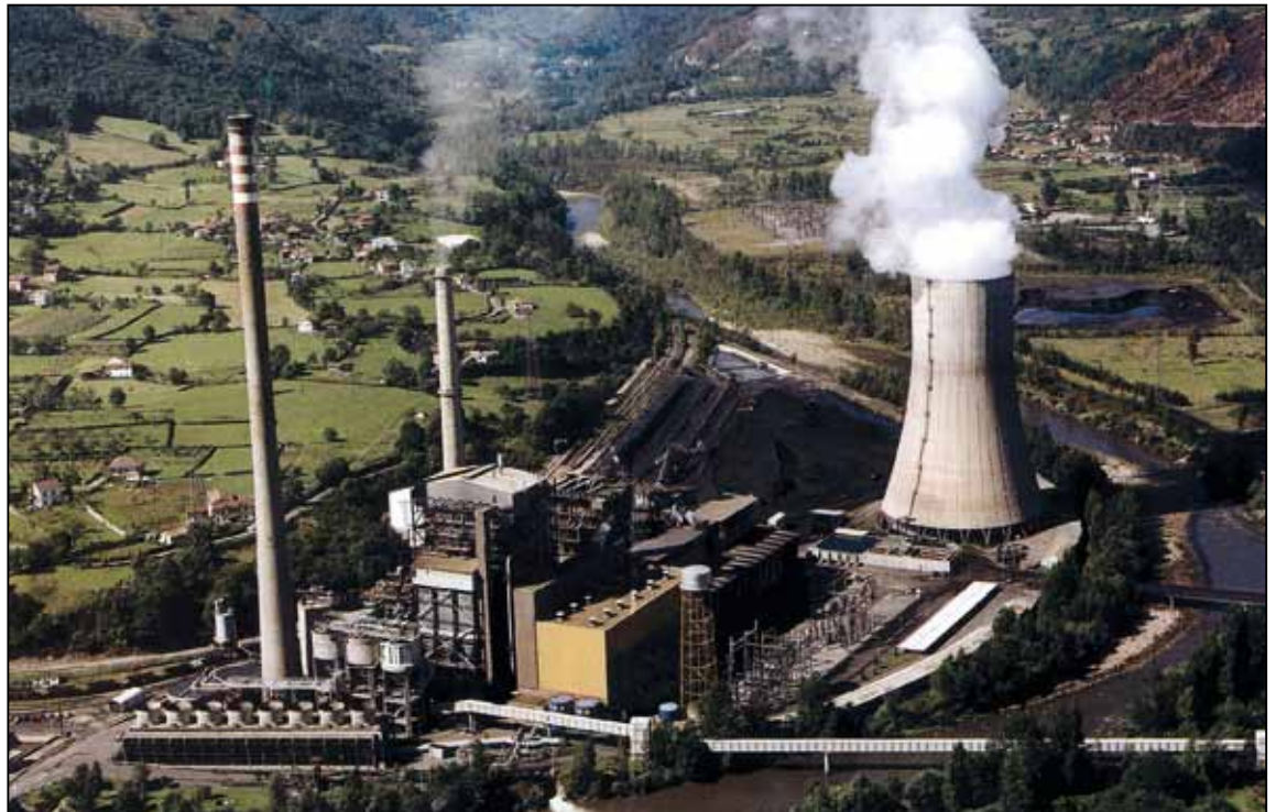
Central térmica de Soto de Ribera, situada en los valles mineros de Asturias.
