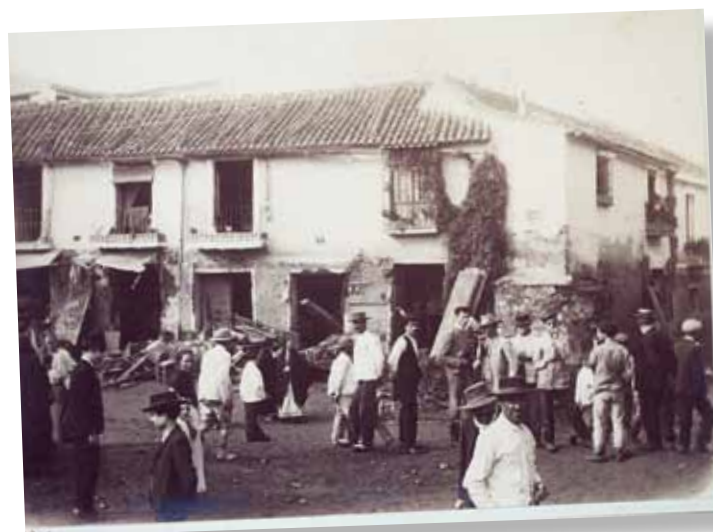
Figura 4. Efectos de las inundaciones de 24 de septiembre de 1907 en Málaga. Fuente Archivo Fotográfico del Ayuntamiento de Málaga.
