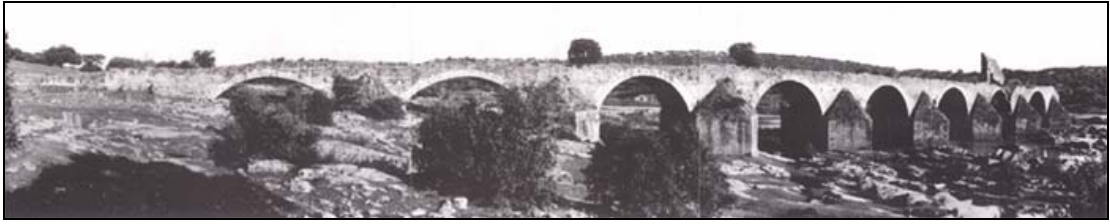
Figura 2 - Ponte da Ajuda - Vista de Jusante
