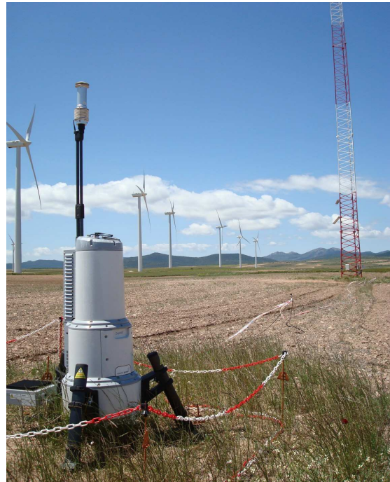
Figura 2. LIDAR, torre anemométrica y parque eólico.
