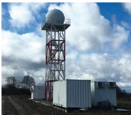
Fig.4.- Instalación del Radar Meteorológico de la banda C en Rozas (Lugo)
